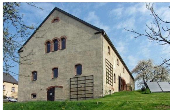
Grundsubstanz in gutem Zustand, aber das Dach musste neu gedeckt werden (Foto: A. Klinger)
