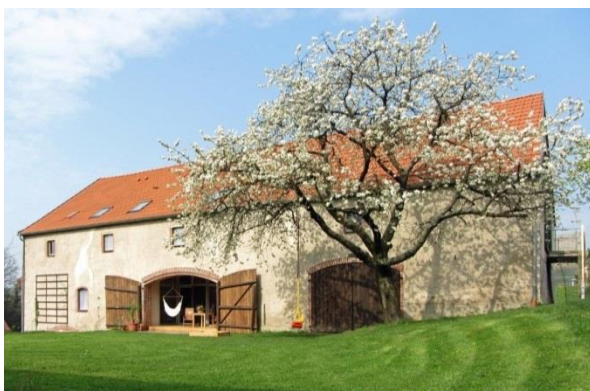
Äußerlich eine solide Scheune, im Inneren modern bewohnbar (Foto: A. Klinger)
