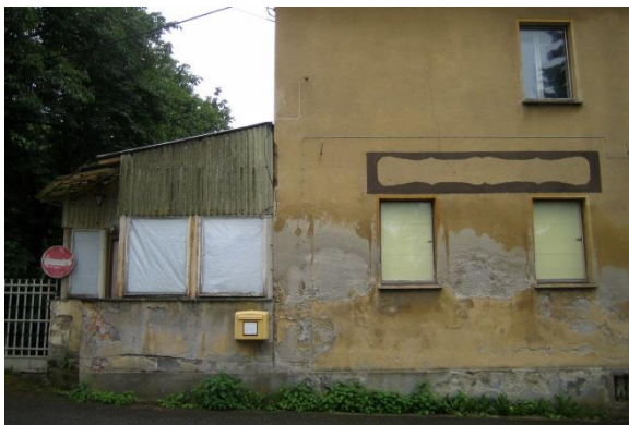
Leerstehendes Objekt in Thiemendorf (Foto: M. Thieme)
