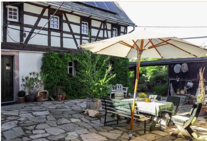
Mit LEADER-Mitteln saniert – Ein denkmalgeschützter Hof in Langenchursdorf, LEADER-Gebiet „Schönbürger Land“, aktuelle Förderperiode (Foto: Detlef ApolinarSKI)
