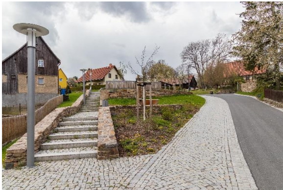
Treppenaufgang und überfahrebarer Fußweg
