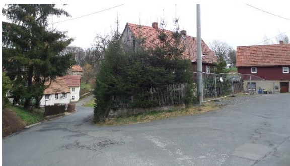
Situation oberer Bereich vor dem Abriss des leerstehenden Wohnhauses
