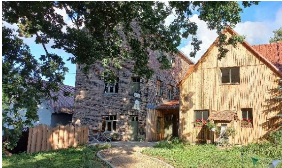
Sanierte Wassermühle Förstgen
