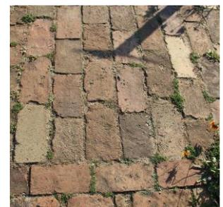
Abb. 5: Pflaster aus Abbruchziegeln
