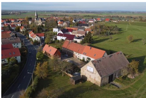
Der über 200 Jahre alte Dreiseithof am Dorfeingang prägt das Ortsbild von Großdobritz
