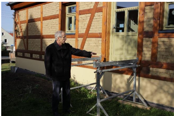
Durch eine rückwärtige Erschließung wird der barrierefreie Zugang ins Obergeschoss möglich
