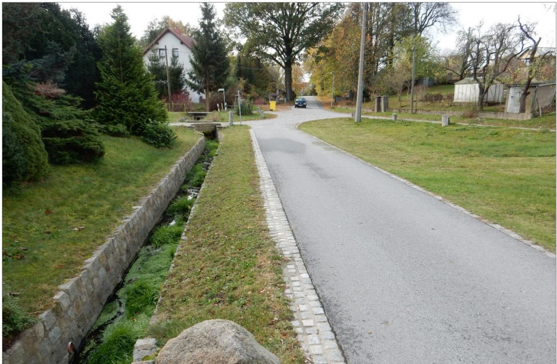
Fahrbahnbegrenzung mit Muldenrinne und Pflasterstreifen, Neubau der Ufermauer (Kirchweg, südlicher Abschnitt)
