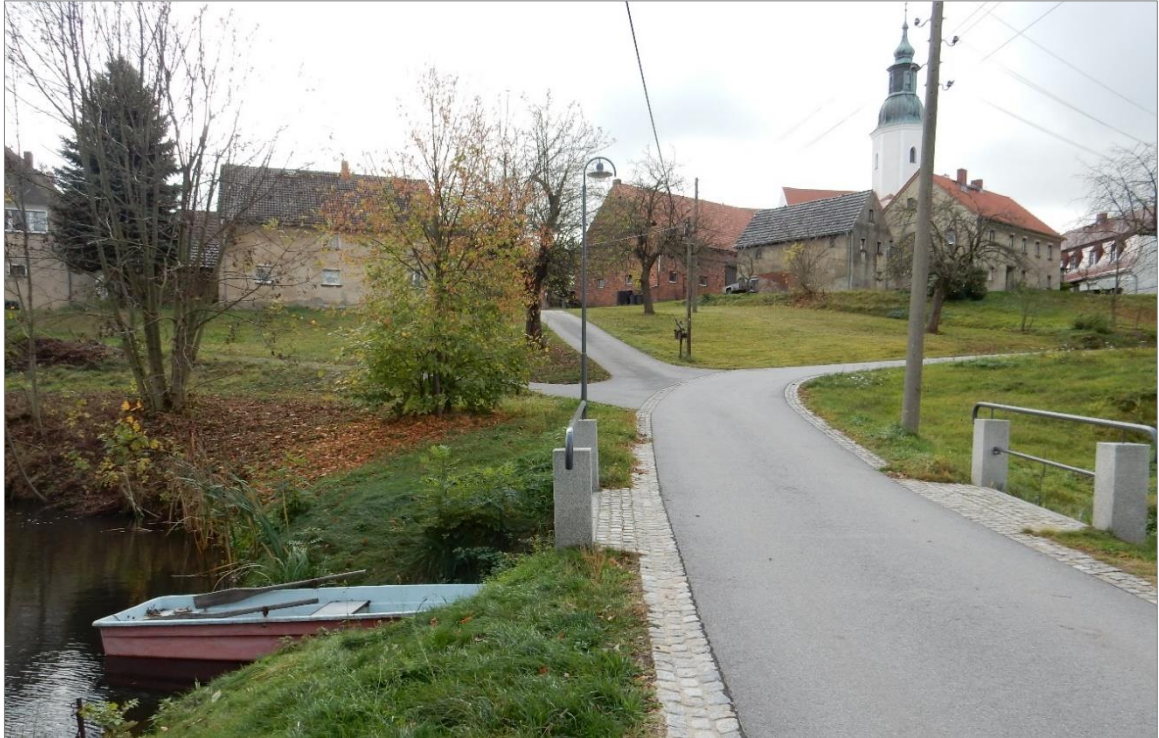
Fahrbahnbegrenzung mit Muldenrinnen (Kirchweg, Abschnitt am Dorfteich)
