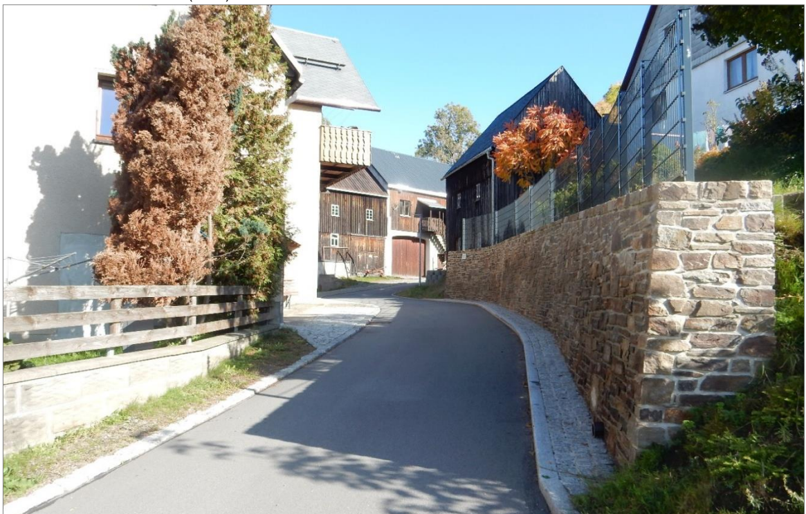
Fahrbahnbegrenzung mit niedrigem Granitbord und Pflasterstreifen, neue Stützmauer aus Naturstein (Zufahrt Dorfstr.)
