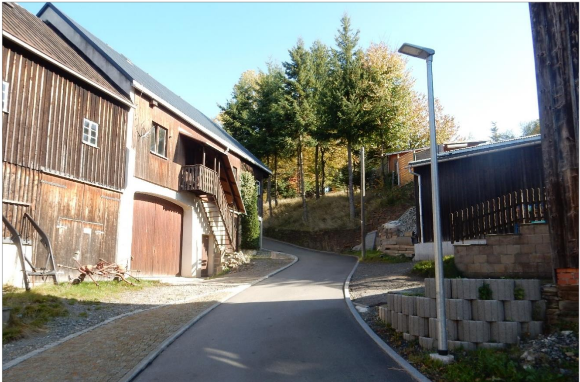
überfahrbare, gepflasterter Seitenbereich, neue Beleuchtung (Anliegerweg, mittlerer Teil)
