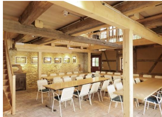
Blick in die Veranstaltungsscheune
