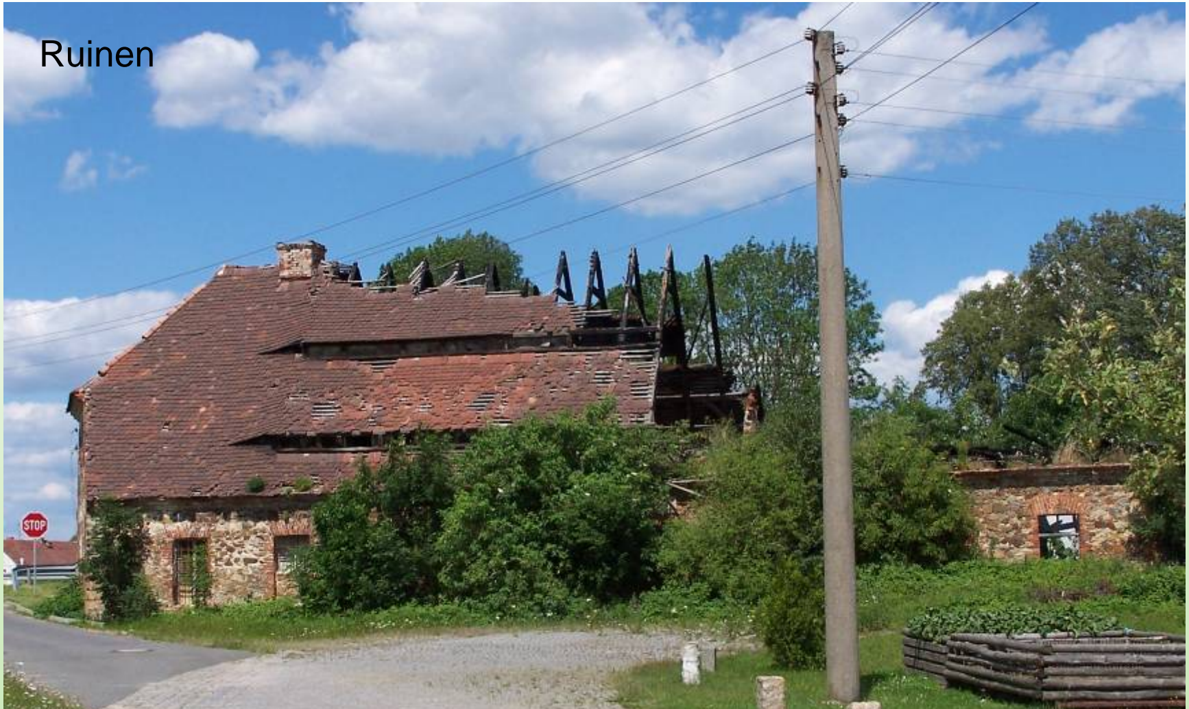
Ruine in Kodersdorf (Niederschlesischer Oberlausitzkreis)
