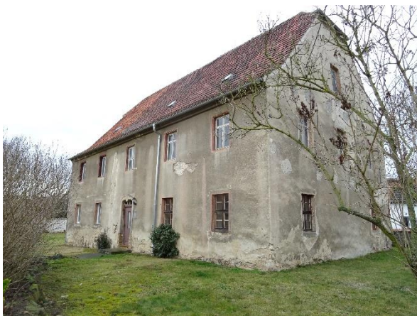
Das Pfarrhaus vor der Sanierung
