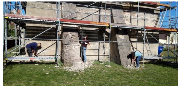
Langenreichenbach in Aktion: Putz abschlagen mit Abstand unter Pandemie-Bedingungen
