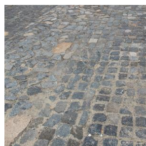
Abb. 4: Wiedereinbau historischen Steinmaterials
