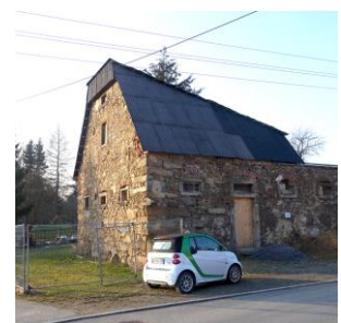
Abb. 5: Blick von der Straße auf ehemaligen Pferdestall
