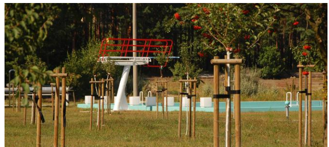
Abb. 3: Erhaltene frühere Sprunganlage
