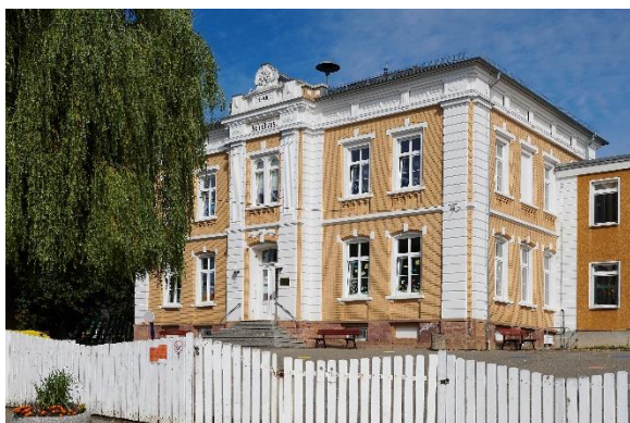
Das ortsbildprägende Schulgebäude aus der Kaiserzeit
