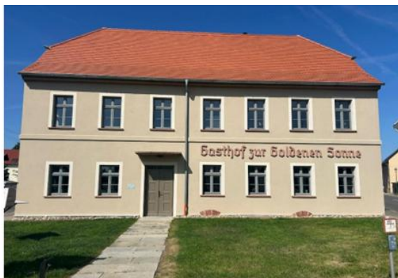
Außenansicht nach der Sanierung
