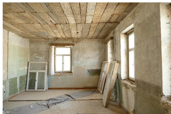
Obergeschoss während der Baumaßnahme
