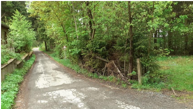
Abbildung 1 Ausgangssituation vor der Umplanung: links beschädigte, standsicherheitsgefährdete Stützmauer; rechts Wiesenfläche mit privater Kleinkläranlage unbekannter Lage und Ausdehnung. © TG Wernitzgrün
