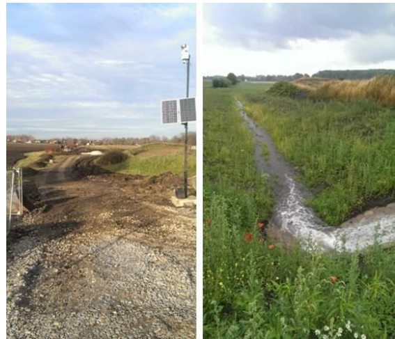
Zulaufgraben noch verrohrt und offengelegter Zulaufgraben in Funktion © TG Ländliche Neuordnung Bubendorf/Benndorf
