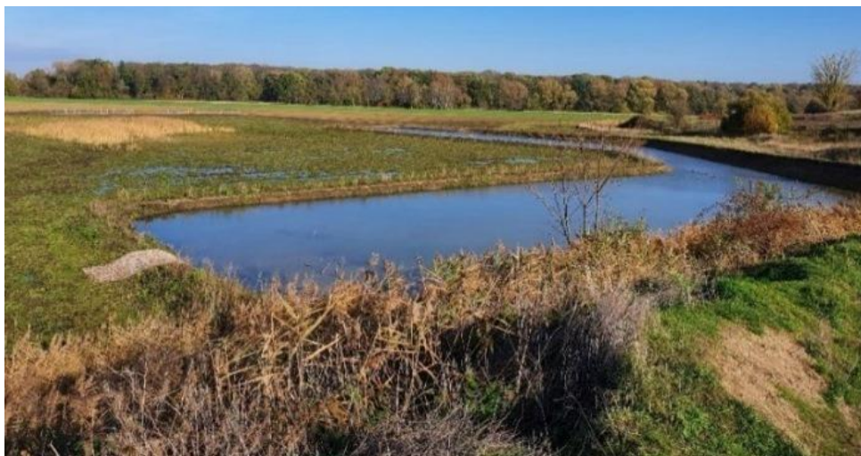
Neues Rückhaltebecken am Floßgraben © TG Ländliche Neuordnung Bubendorf/Benndorf
