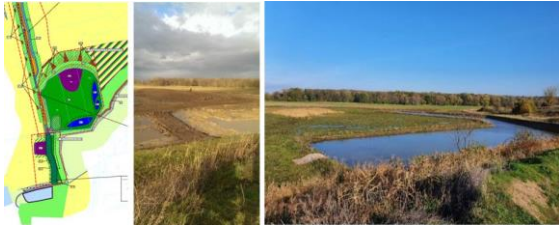
Regenrückhaltebecken Plan, während des Baues und nach Fertigstellung © Planungsbüro IIT GmbH / TG Ländliche Neuordnung Bubendorf/Benndorf
