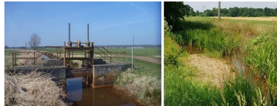
Abbildung 4: links: Altes Wehr; rechts: neu gestalteter Schwarzbach ©Thorsten Hindemith
