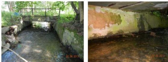
Abbildung 3: links: Obere Brücke, Außenansicht; rechts: Obere Brücke, rostige Trägerflansche © LRA Vogtlandkreis
