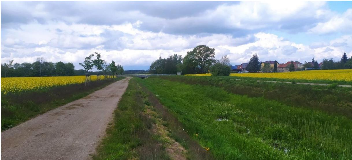
Abbildung 1: Der im Flurbereinigungsverfahren »Hochwasserschutz Groß Särchen« neu errichtete Umfluter mit Begleitweg und Baumreihe. © Teilnehmergeinschaft Groß Särchen
