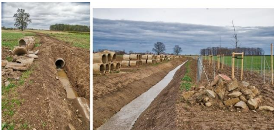
Abbildung 5: verrohrte Rietzschke Abbildung 6: neu angelegte Rietzschke mit Bepflanzung des südlichen Gewässerrandstreifens © LRA Leipzig
