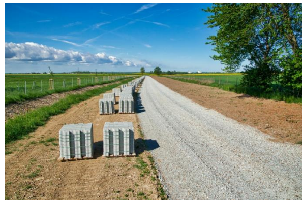
Abbildung 7: Unterbau für die Pflasterung © LRA Leipzig
