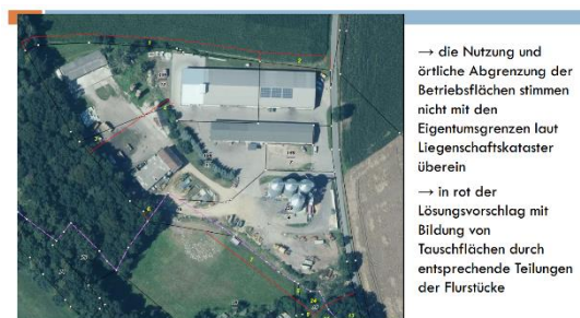
Abbildung 2: Situation rund um die Betriebsflächen des Antragstellers © Sächsische Landsiedlung GmbH/ Geodaten Sachsen (GeoSN)
