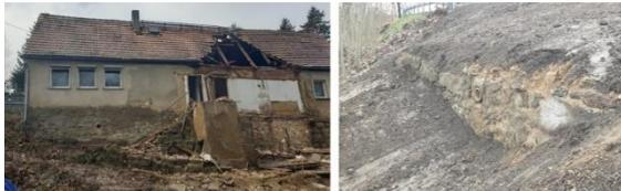
Abbildungen 4 und 5: links: Abrisshaus an der S115; rechts: Einflugloch in den erhalten gebliebenen Gewölbekeller; © TG Cunewalde
