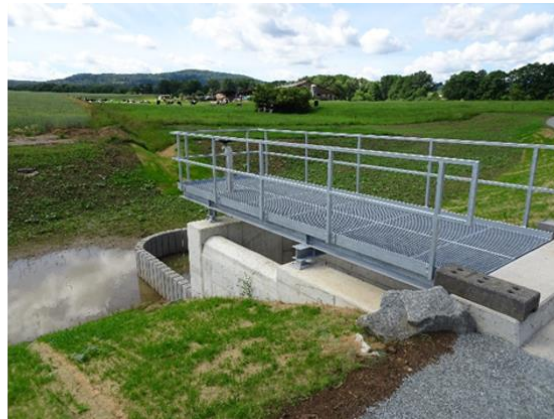
Abbildung 6 – rechts: Bedienbrücke und Sedimentfang © TG Bertsdorf-Hörnitz
