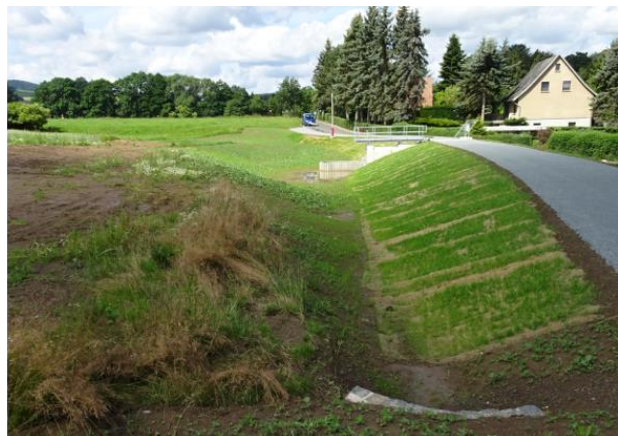
Abbildung 3 - links: Blick Richtung Westen Hochwasserrückhaltedamm mit Schranke © TG Bertsdorf-Hörnitz Abbildung 4 - rechts: Durchlassbauwerk und Trockenbecken © TG Bertsdorf-Hörnitz
