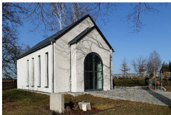
Der Haupteingang zur Trauerhalle
