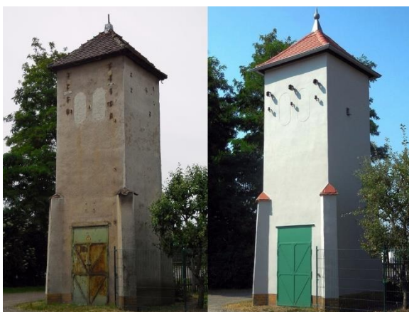
Der Trafoturm vor und nach der Sanierung
