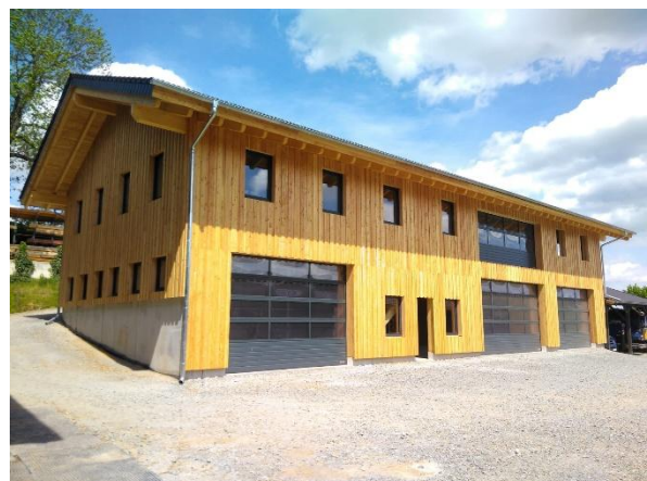
Die Abbundhalle nach der Fertigstellung
