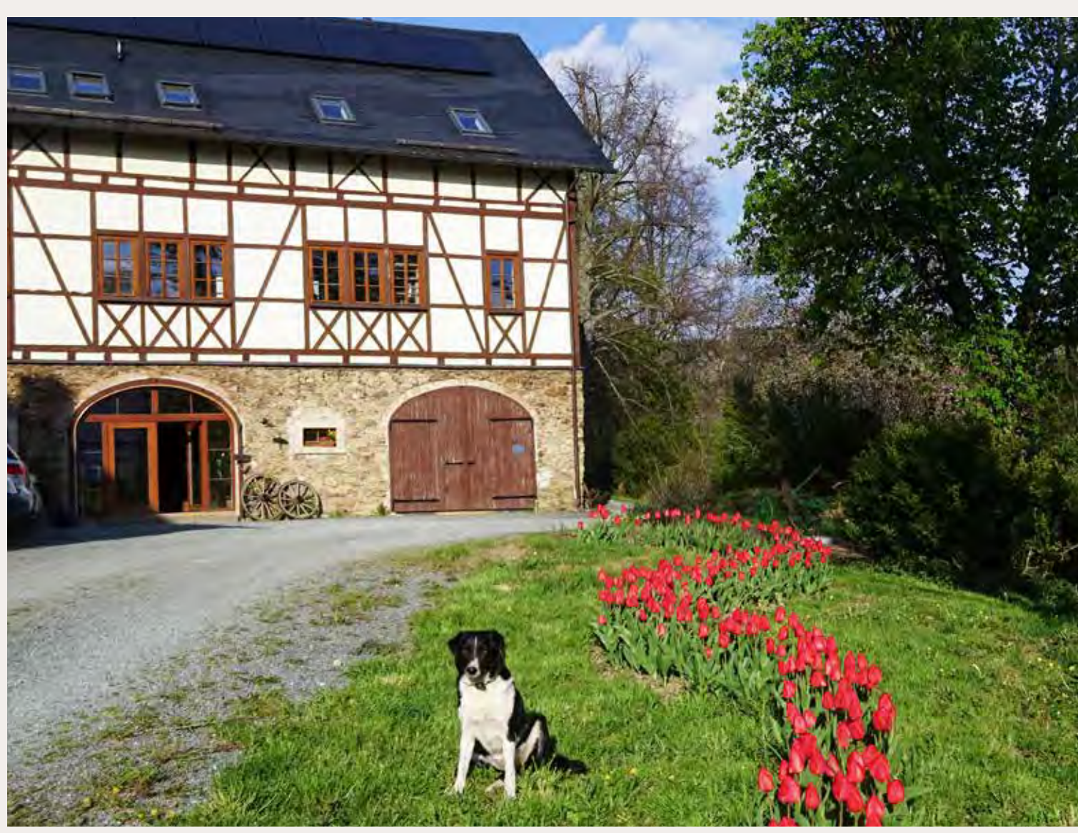
Eine denkmalgeschützte Scheune in Drebach OT Grießbach wurde zu Wohnraum umgebaut und Lebensraum für mehrere Generationen geschaffen
