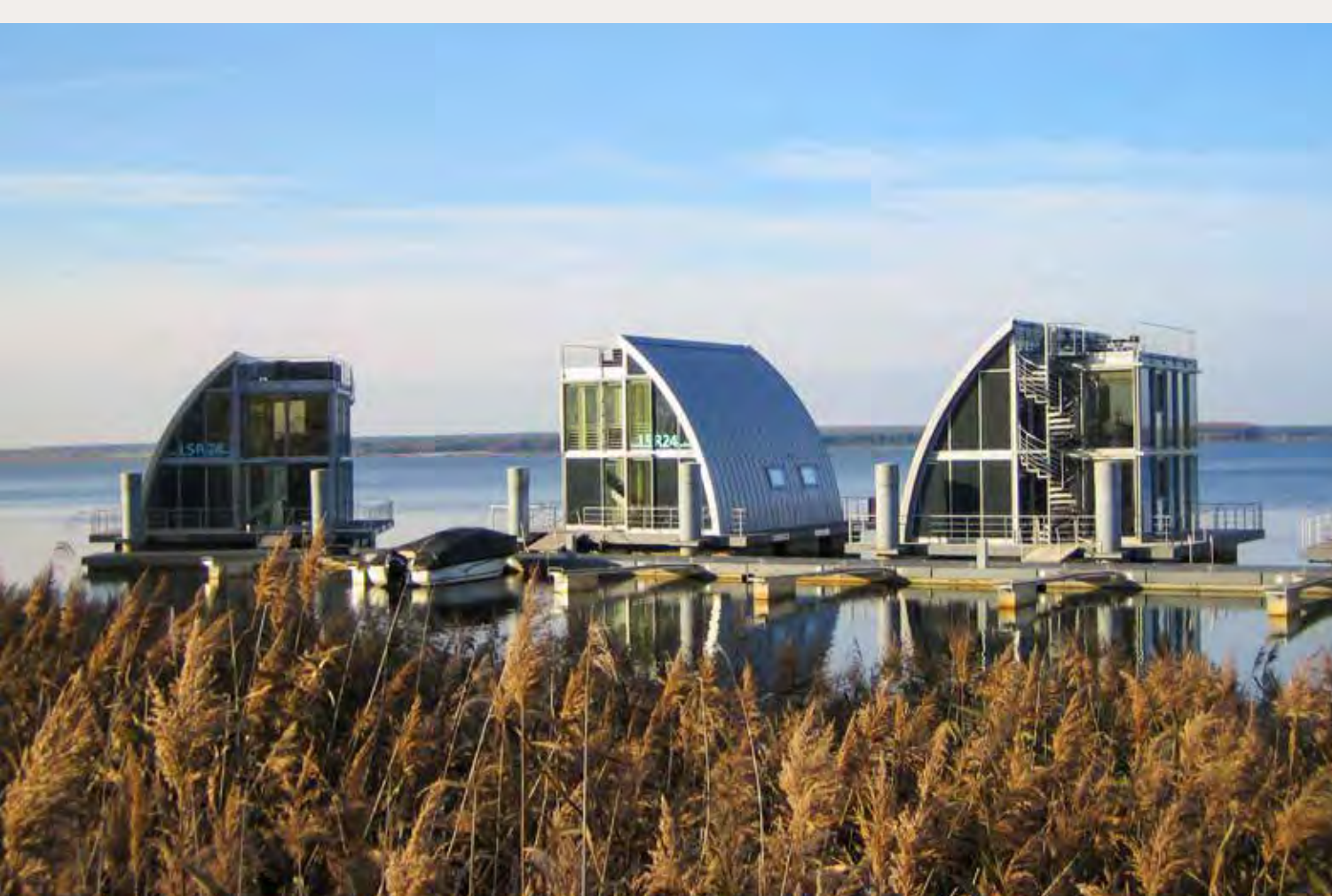
Schwimmende Häuser am Geierswalder See © Sweco GmbH
