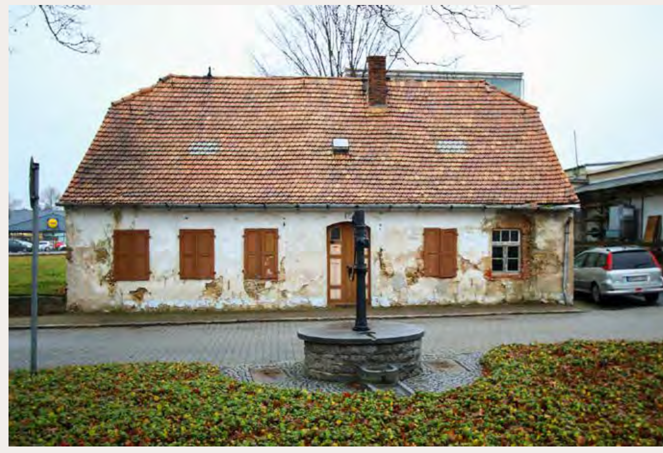
links u. oben: Sanierung der denkmalgeschützten Schmiede des Jägerhofes in Königsbrück zu einer Osteopathiepraxis © Andreas Bednarek
